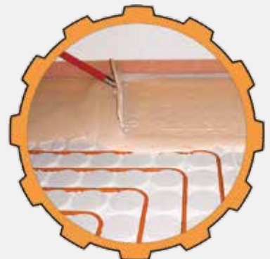
Vulmassa aanbrengen
